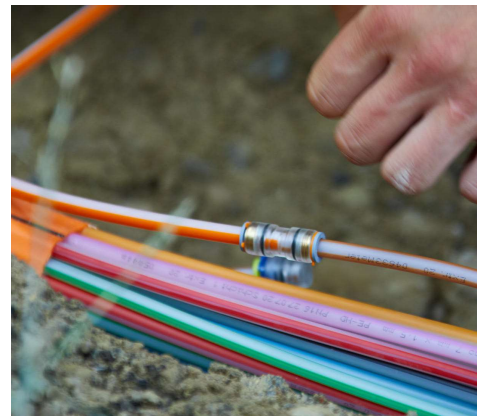
Glasfaser-Kabel zum Haus
